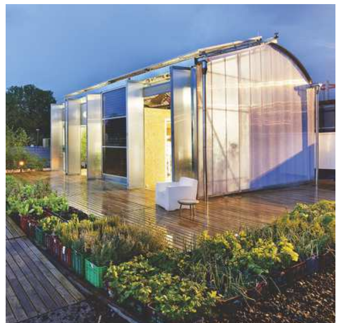
Zelfvoorzienende compacte zonnewoning. Foto : www.cabinzoom.com
